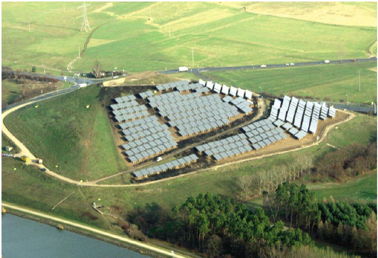
Abb. 5 Solarkraftwerk auf der Deponie „Atzenhof“, Fürth (ca. 1 MW)
