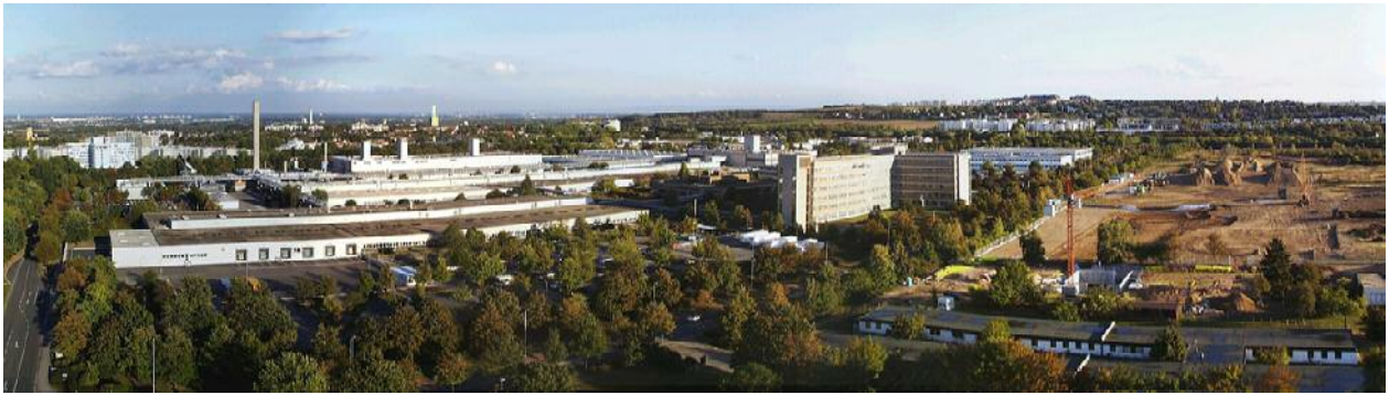
Abb. 1 Park- und Gewerbeflächen auf der Deponie „Hechtsheimer Straße“, Mainz (ca. 20 Hektar)
