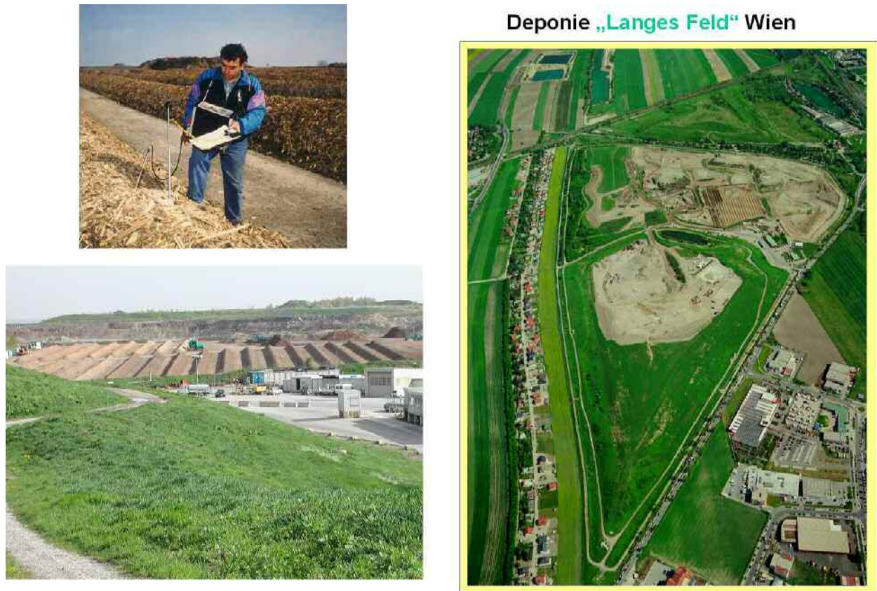
Abbildung 5 Tägliche Gasmessungen – Mietenaufbau für eine Deponieabdeckung
