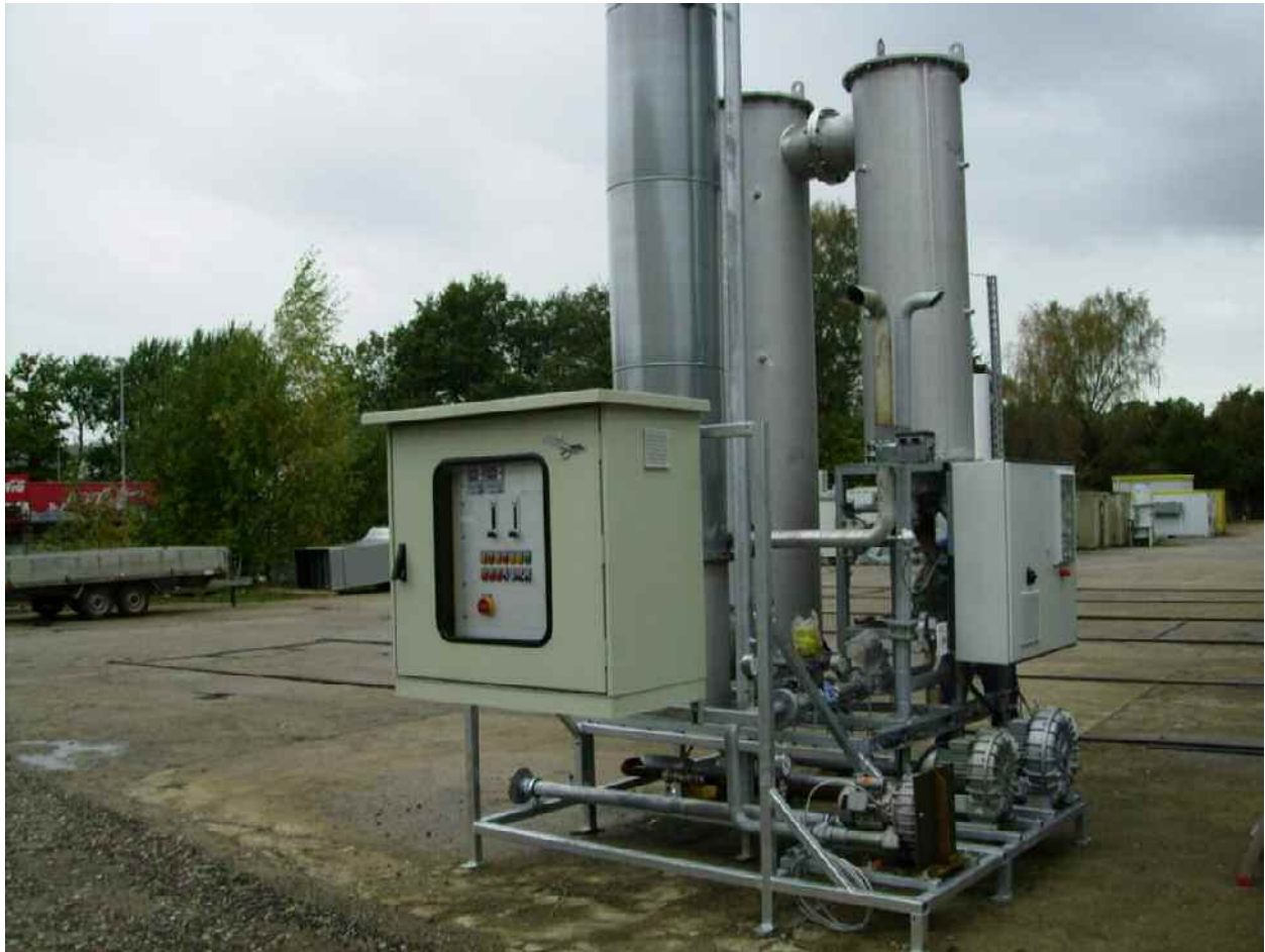
Abbildung 11 HAASE-Schwachgasfackel im Werk Neumünster
