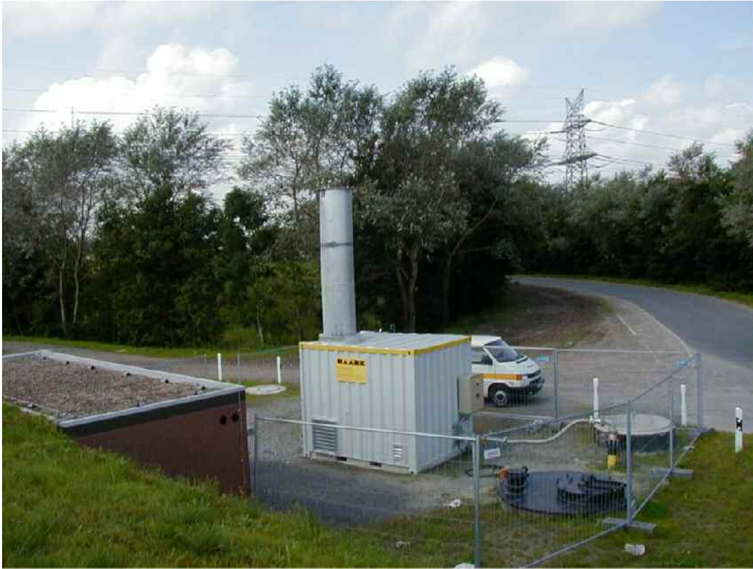
Abbildung 7 Deponiegasverdichter- und Fackelanlage (750 kW)
