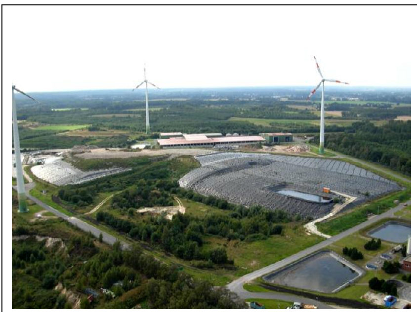
Bild 1: Deponie Wilsum II / Entsorgungszentrum Wilsum
