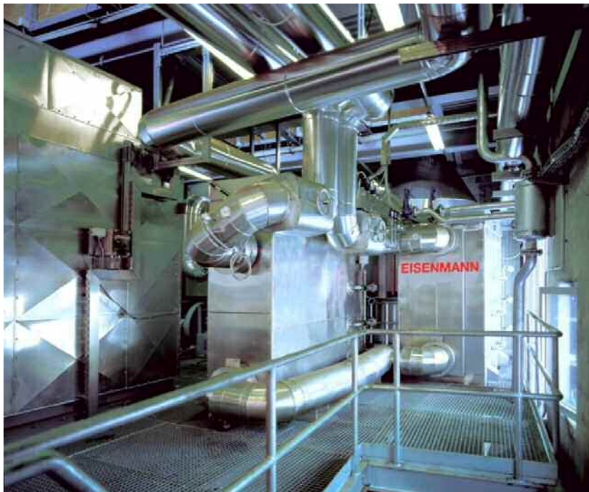
Abbildung 4 Wärmerückgewinnung zur Erhitzung von Thermalöl
