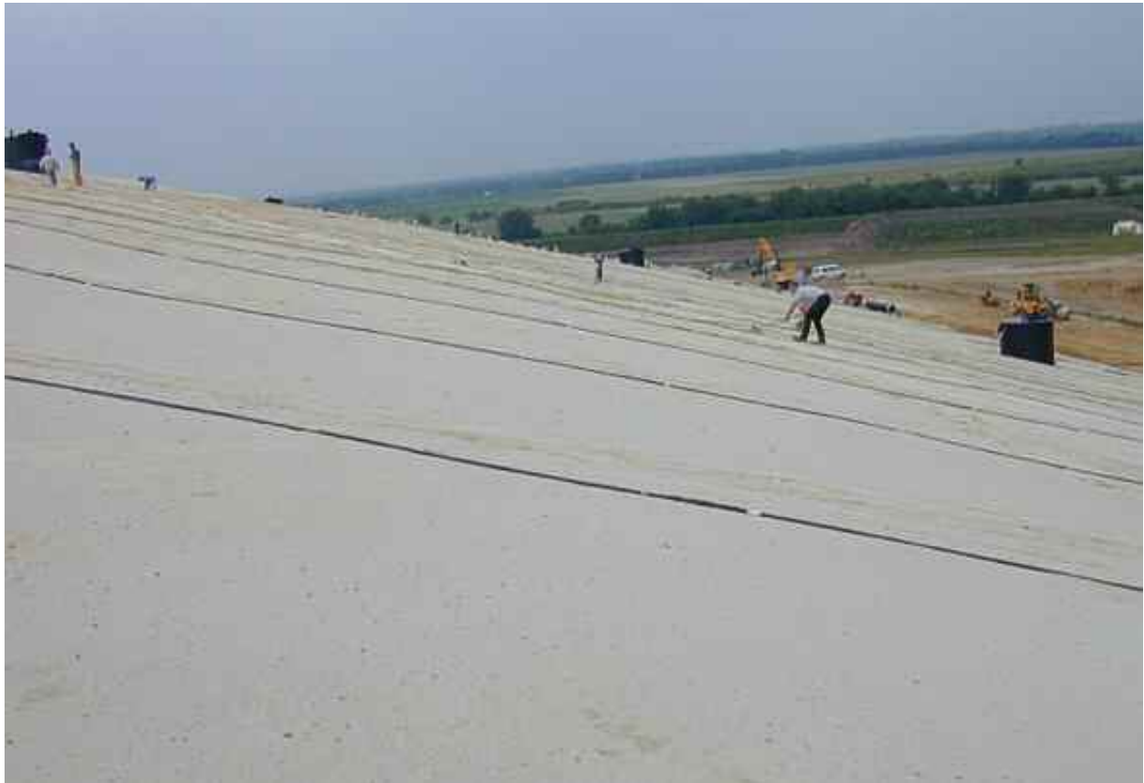
Abbildung 4 Verlegung der Messelektroden unterhalb der Kunststoffdichtungsbahn
