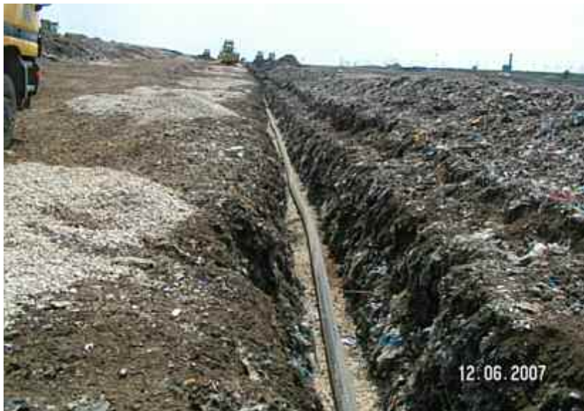
Bild 3 Ausführungsbeispiel einer Entgasungsrigole
