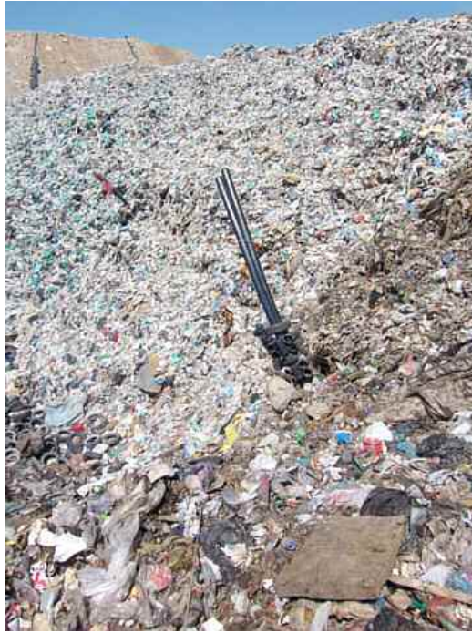
Bild 4 Hangschüttung mit kontinuierlicher Müllverlagerung
