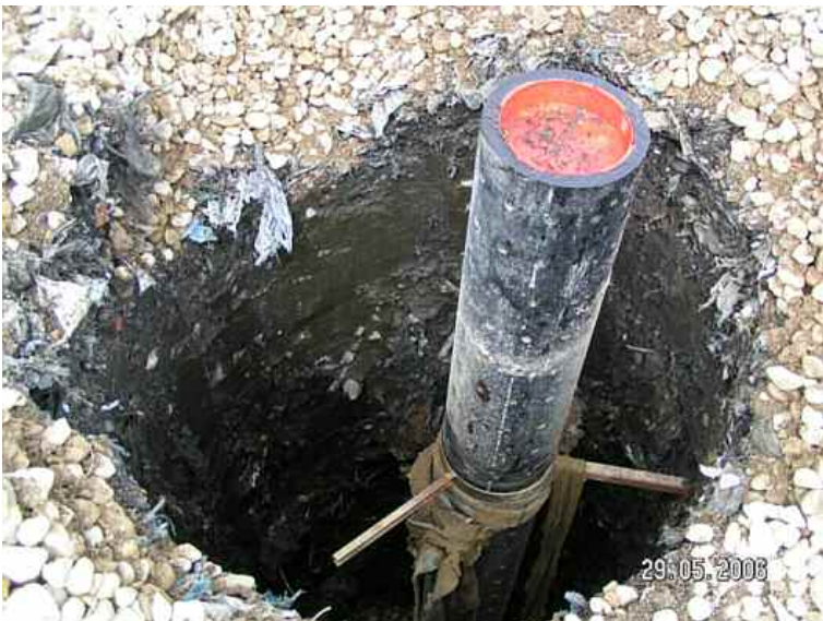
Bild 2 Ausführungsbeispiel eines Vertikalbrunnens
